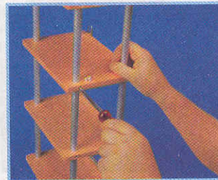
Алюминиевые уголки у задних кромок полок предотвращают соскальзывание и падение компакт-дисков. Для навешивания этажерки на стену используются две петли.
